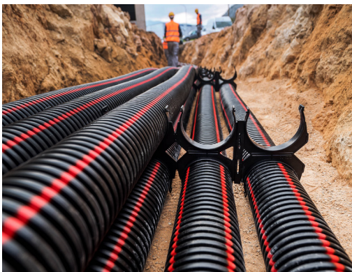
Παράδειγμα εγκατάστασης με τη χρήση διαχωριστών ανάμεσα στους σωλήνες
