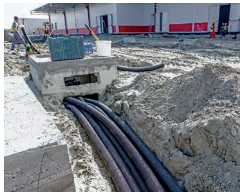
Παράδειγμα εγκατάστασης με τη τοποθέτηση σωλήνων χύδην στο όρυγμα
