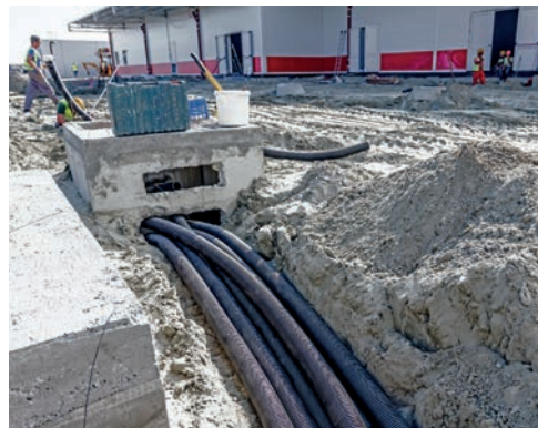
Παράδειγμα εγκατάστασης με τη τοποθέτηση σωλήνων χύδην στο όρυγμα
